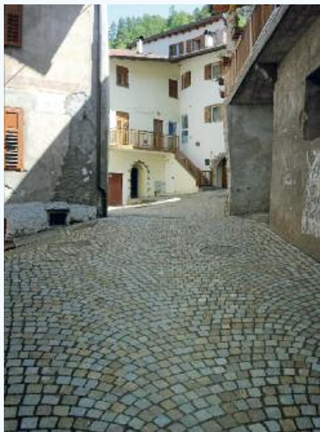
Pavimentazione di porfido sulla via che da Stedro scende verso Pianezza
