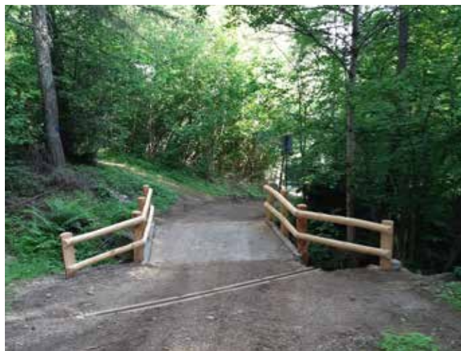
Strada Valcava, Ponte in località Mandre
